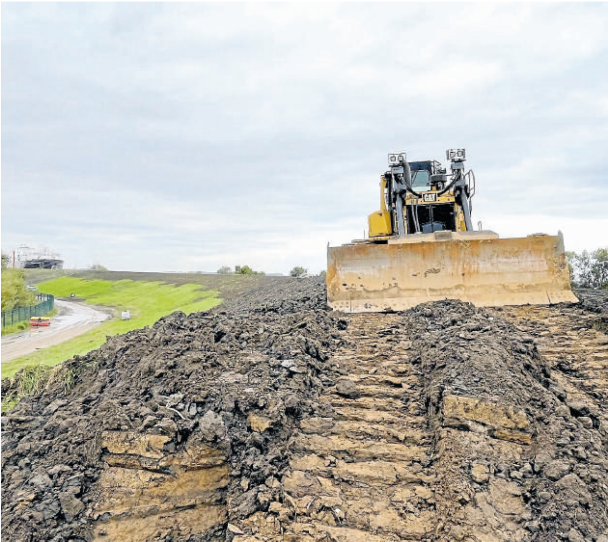
So wird es zehn Jahre lang zwischen dem Lühe-Anleger und Schöpfwerk Twielenfleth aussehen: Die Raupe modelliert hier Satellitenunterstützt den neuen Deich in Stadersand, im Hintergrund liegt das schwimmende LNG-Terminal. Fotos: Vasel
