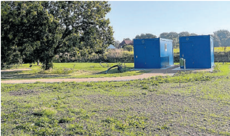
Die Sanitärcontainer sollen noch künstlerisch gestaltet werden.
