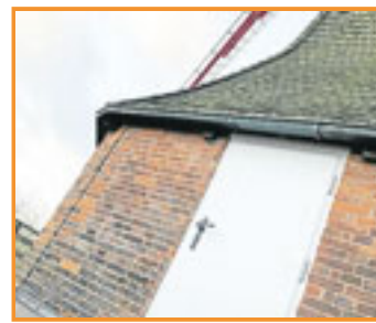
Nachgebaute historische Tür in der denkmalgeschützten Jorker Mühle.
