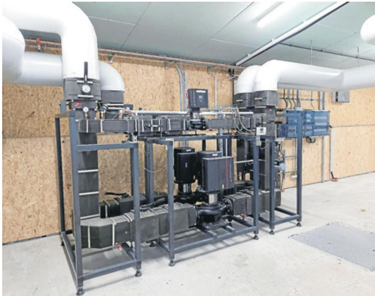
*Für die Gemeinde Oerrel hat der in Bargstedt ansässige Betrieb Fischer ein Wärmenetzwerk für 100 Abnehmer realisiert, das seine Energie von einer Holzhäcksel-Heizung bezieht. Verbaut wurde auch eine hochmoderne Absauganlage, um die Feinstaubemissionen zu minimieren.*
