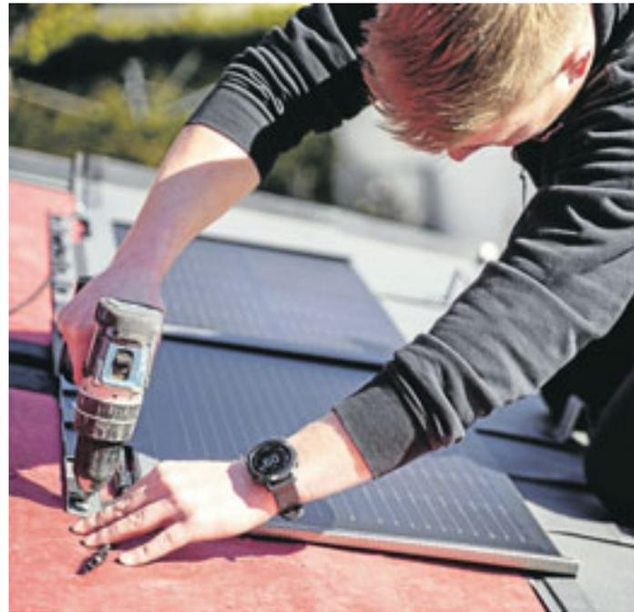
Leistungstarke Fotovoltaik-Technologie: Jetzt gibt es auch Aluminium-Dachplatten mit integrierter PV-Anlage. Fotos: HLC/PrefalCroce&Wir
