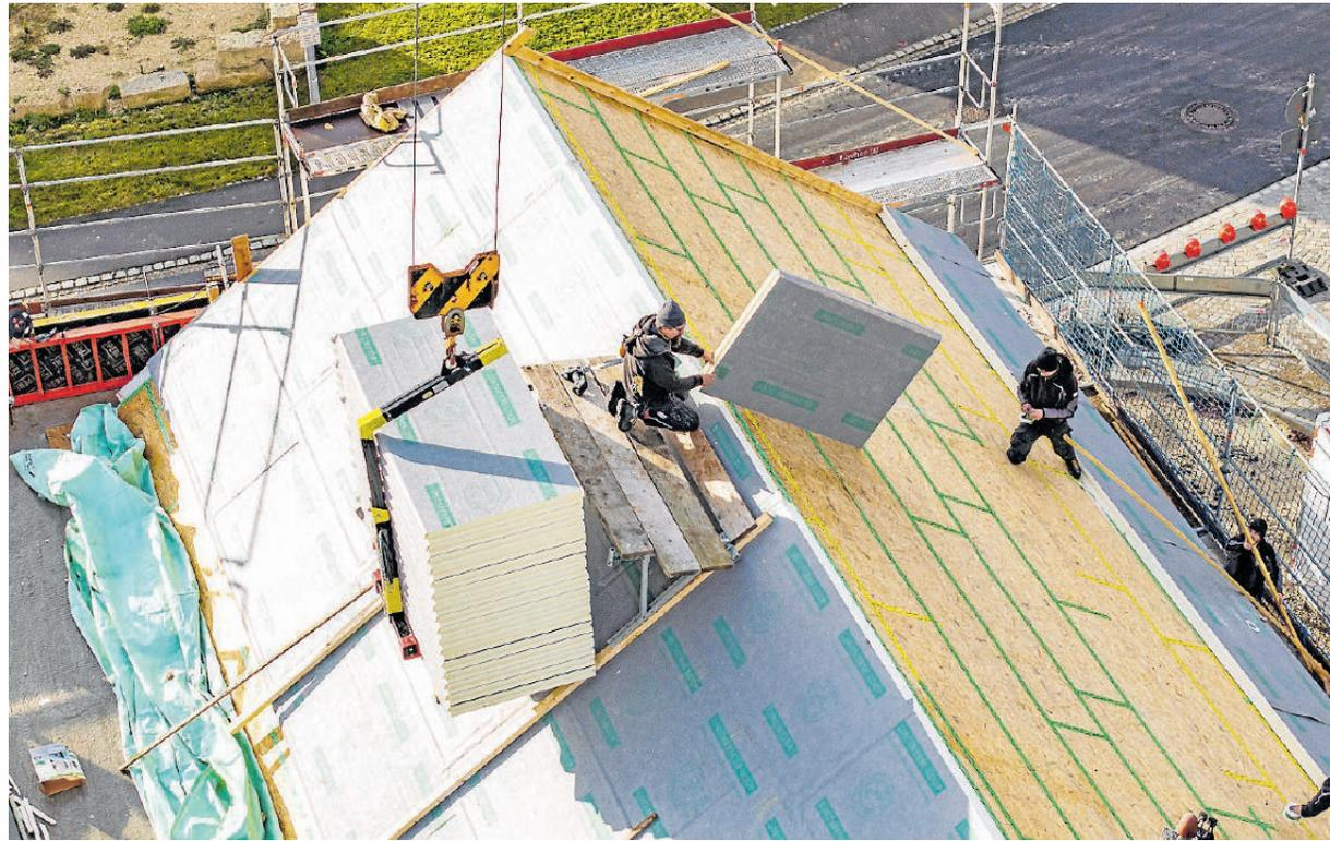
Die biobasierten Dämmstoffe sind aufgrund ihres geringen Gewichtes gut zu handhaben. Das erleichtert die Arbeit der Handwerker auf der Baustelle, die während der Montage mit baustellenüblichem Werkzeug arbeiten können.
