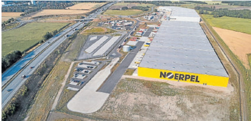
Ein Beispiel für die Arbeitsweise der Immobilien-Services ist der LogIn-Park in Elsdorf.
