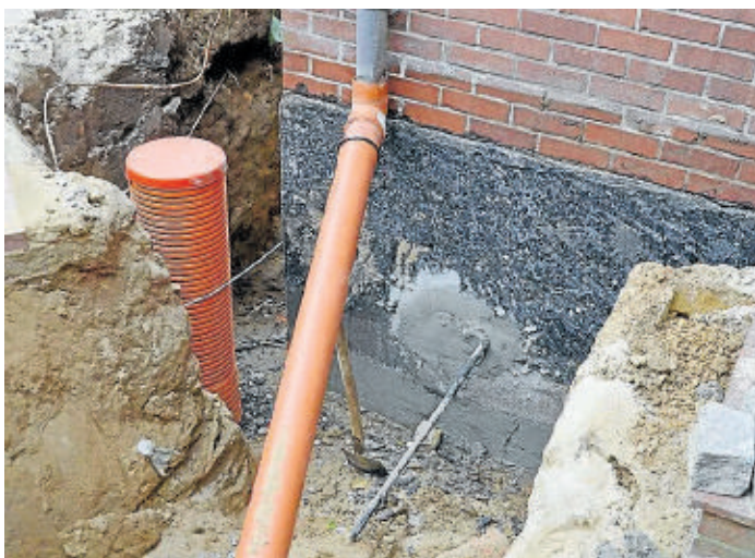
Das von außen freigelegte Mauerwerk des Kellergeschosses wird professionell neu abgedichtet und von dem Moment an dauerhaft für einen wunderbar trockenen Keller sorgen.
