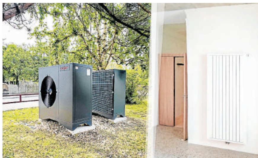
Der Aluminium-Heizkörper ist speziell für den Betrieb mit geringen Vorlauftemperaturen von maximal 45 °C konzipiert und arbeitet komplett ohne elektrischen Motor, wie es üblicherweise bei Wärmepumpen-Heizkörpern der Fall ist.
