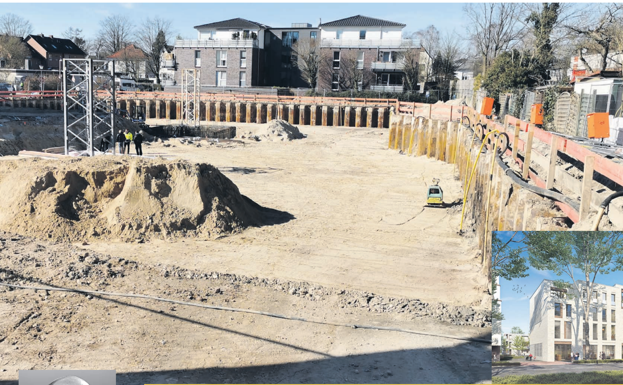
Ein Blick in die komplizierte Baugrube: Die Spundwand steht.
