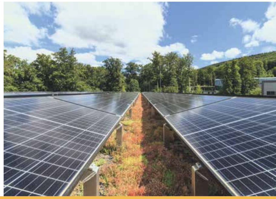
Technik und ein begrüntes Dach schließen sich nicht aus. Fotos: Harms
