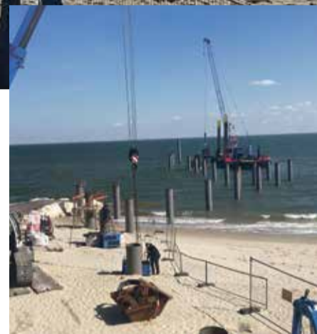
Auf dem Arbeitsschiff steht ein Seilbagger, der den Rüttler samt Pfahl punktgenau platziert.
