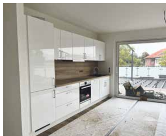
Mitte September wurde die erste Küchenzeile eingebaut – der Ausbau geht auf die Zielgerade.
