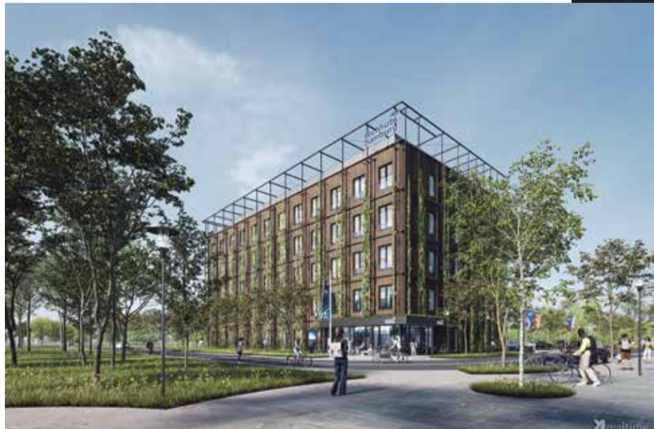
Der erste Baustein der Science City in Altona: Der techHub Hamburg bietet Labor- und Büroflächen für junge Unternehmen aus den Bereichen Biologie und Chemie. Das Gebäude hat fünf Vollgeschosse und wird derzeit in Modulbauweise erstellt.
