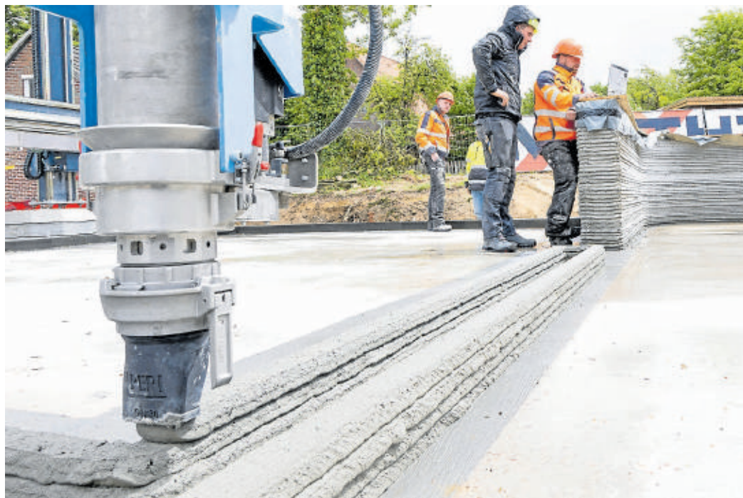
In Selsingen erstellt Matthäi gerade Norddeutschlands erstes Gebäude, das aus einem 3-D-Drucker stammt. Schicht für Schicht entstehen die Wände, exakt vom Computer gesteuert.
