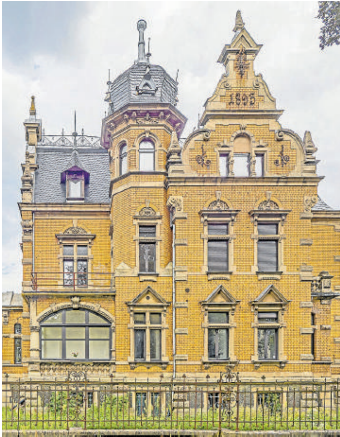
Die denkmalgeschützte Gründerzeit-Villa wurde nach mehr als 30 Jahren Leerstand saniert. Fotos: UdiDämmsysteme
