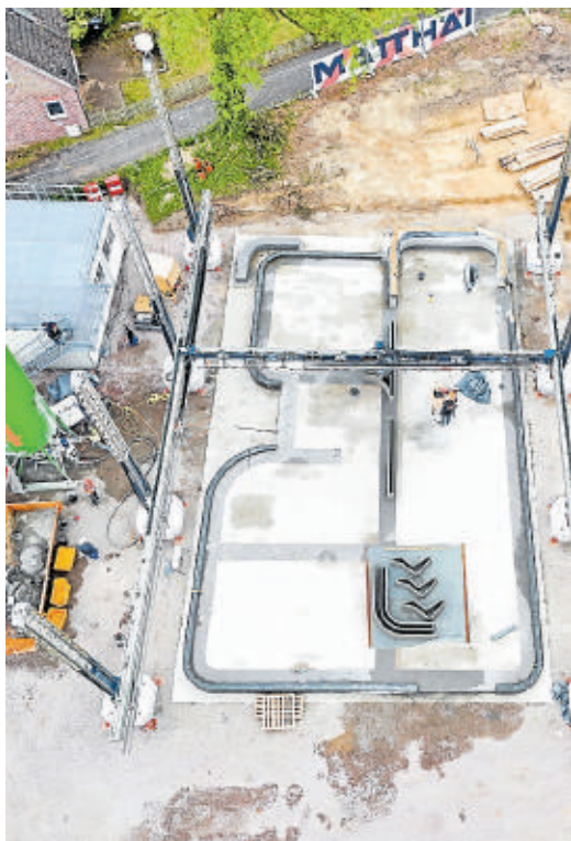
In Selsingen erstellt Matthäi gerade Norddeutschlands erstes Gebäude, das aus einem 3-D-Drucker stammt. Schicht für Schicht entstehen die Wände, exakt vom Computer gesteuert.
