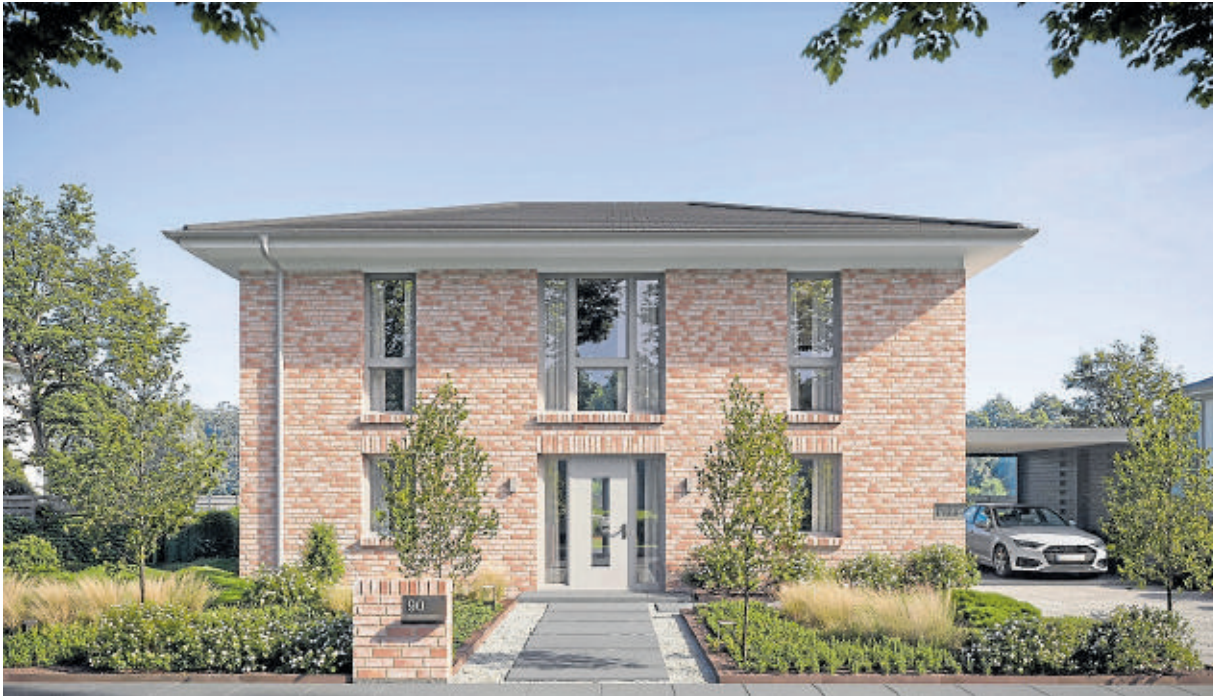
Walmdach mit 22-Grad-Dachneigung, zweigeschossiger Baustil mit massiver Stahlbetondecke im Obergeschoss: Die neue Stadtvilla von Viebrockhaus geizt nicht mit Reizen, jedoch beim Budget. Fotos: Viebrockhaus
