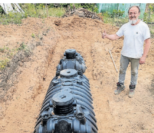
Regenwassernutzung und Versickerung einfach selber eingebaut.
