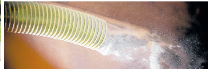
Foto oben: Das in puncto Architektur und Nachhaltigkeit außergewöhnliche Haus wurde in Holzständerbauweise gebaut. Die Sparren sollten als statisches und ästhetisches Element sichtbar bleiben. Foto unten: Der Cellulosedämmstoff wird maschinell in die Hohlräume eingeblasen und füllt jede Nische fugenlos aus.
