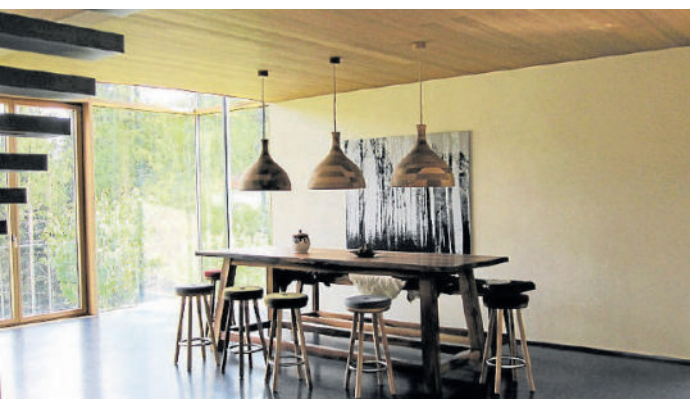
Im Innenbereich sorgt feuchteregulierender Lehmputz für ein angenehmes und wohngesundes Raumklima.
