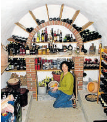
Klassische Gewölbekeller aus Ziegeln benötigen keine elektrische Kühlung.
