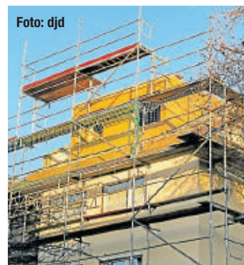
Foto: djd Durch eine Dachaufstockung in Holzbauweise können Wohnhäuser zusätzliche Wohnfläche bekommen.
