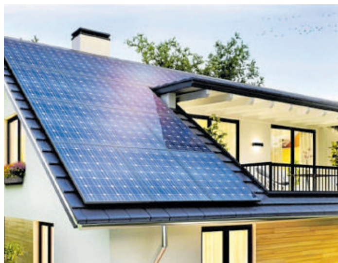
Photovoltaikanlagen sorgen für Strom im eigenen Haus und bringen, eingespeist ins Energienetz, auch noch Geld in die Haushaltskasse.
